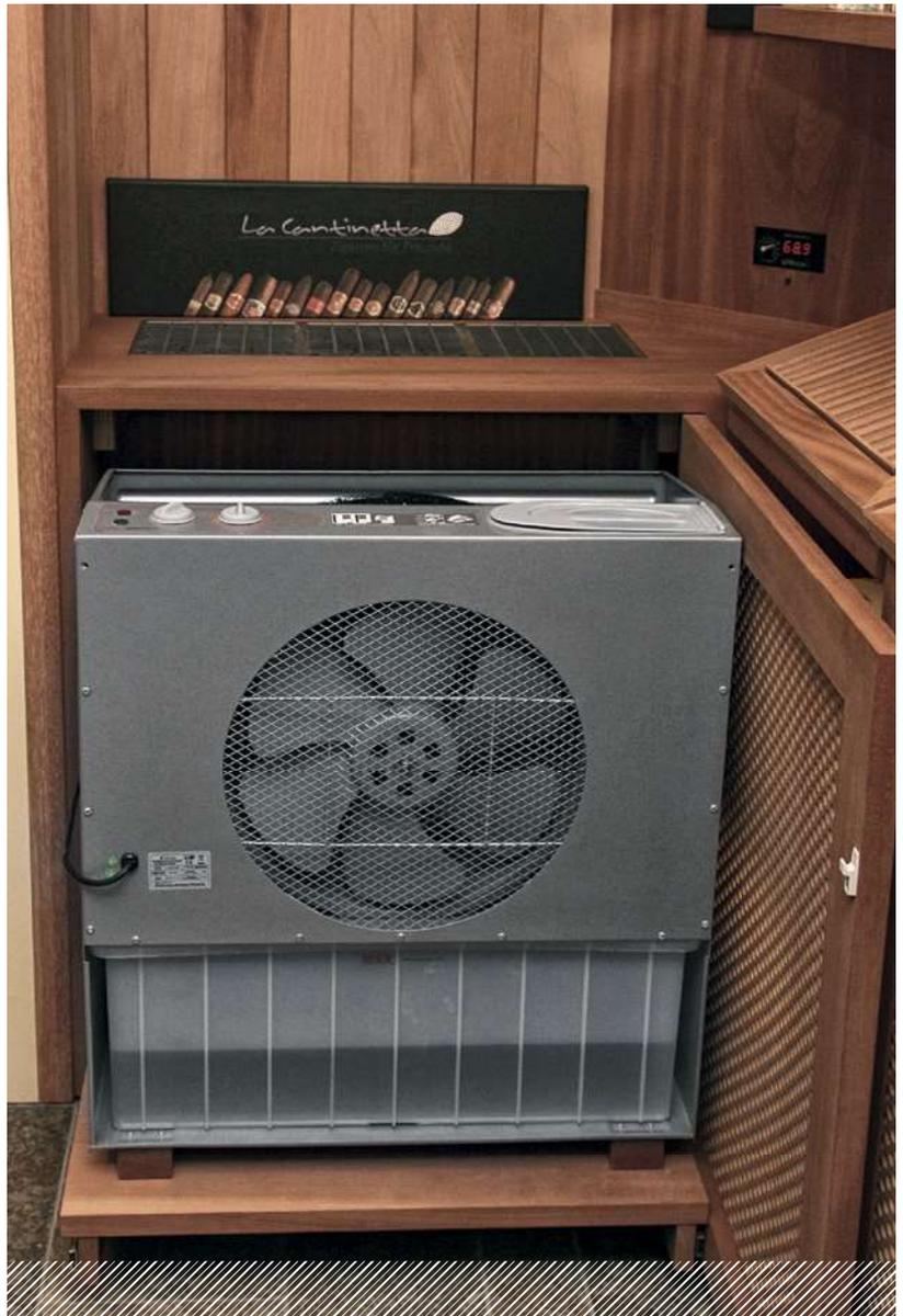
steht das Befeuchtungssystem. Der entstehende Totraum im Eck kann zur Installation eines Dauerumlufsystems perfekt genutzt werden. Dabei wird die Luft im unteren Sockelbereich angesaugt und oben im Raum wieder eingeblasen. Somit entstehen auch dann keine Feuchte- nester und Trocken zonen, wenn der Befeuchter nicht aktiv ist.
